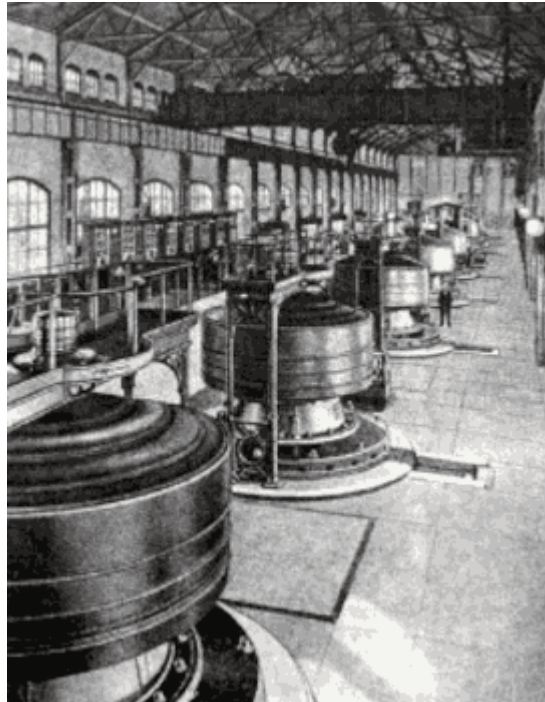
Sala de generadores de la central eléctrica número 1 de la planta hidroeléctrica del Niágara, bautizada como central Edward Dean Adams.
