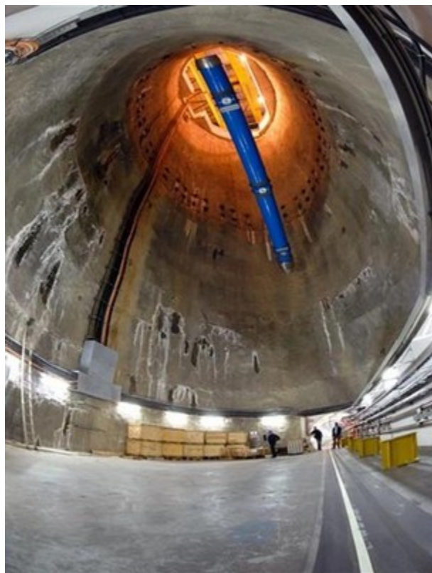
Figura 3. Imanes dipolares del LHC descendiendo a 100 m de profundidad para su instalación. Fuente: CERN.
