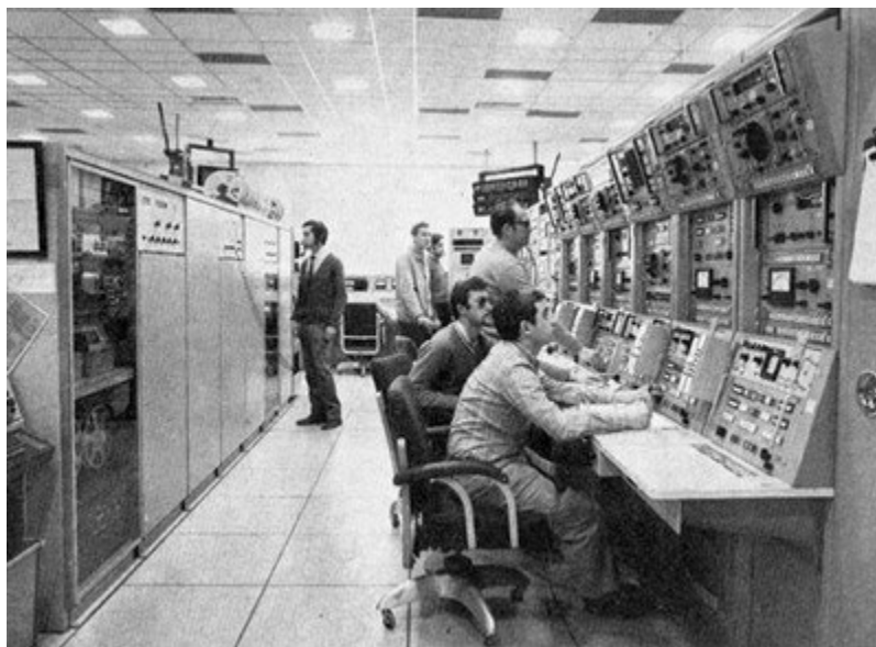
Figura 14. Fresnedillas. En primer plano consola de Receptores en la sección de Radiofrecuencia, y al fondo la consola del Servo (Antena).
