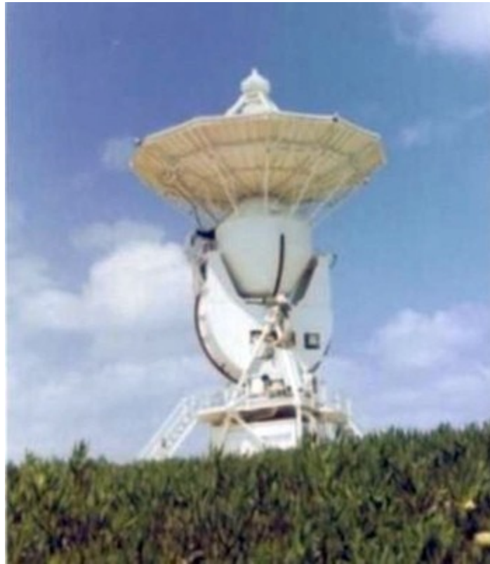
Figura 8. Maspalomas. Antena parabólica de 9 m de diámetro. John Glenn, que fue el primer norteamericano en orbitar la Tierra (22/2/1962), reportó desde su cápsula Friendship 7 (Amistad 7): "A la vista, las Islas Canarias ¡qué paisaje!"
