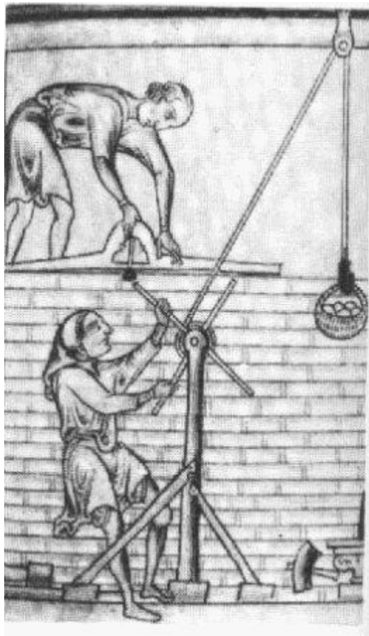
Figura 14. Los albañiles llevaban consigo un equipo de herramientas livianas. La vertical se fijaba con una plomada; y la horizontal se fijaba, no con el nivel de burbuja, sino con una plomada unida a un ángulo recto. Albañiles trabajando, siglo XIII.
