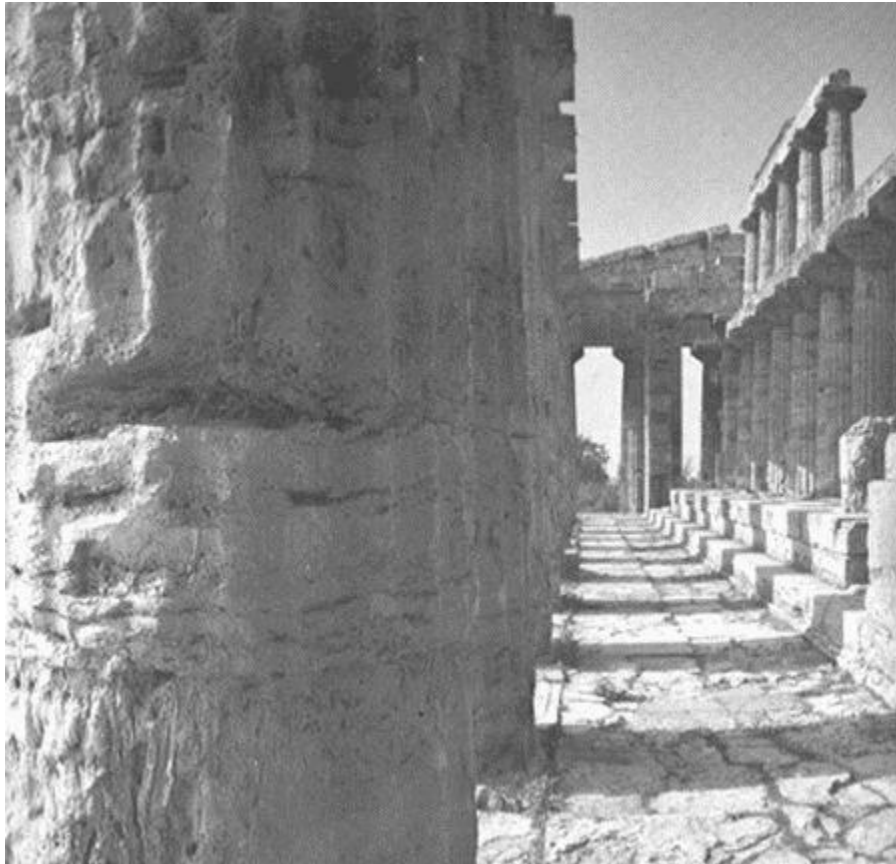
Figura 12. Los templos griegos fueron construidos en ángulos rectos, siempre en escuadra. Templo de Poseidón en Pesto, en el sur de Italia. Las dos hileras de columnas constituyen un sistema para aligerar la estructura.
