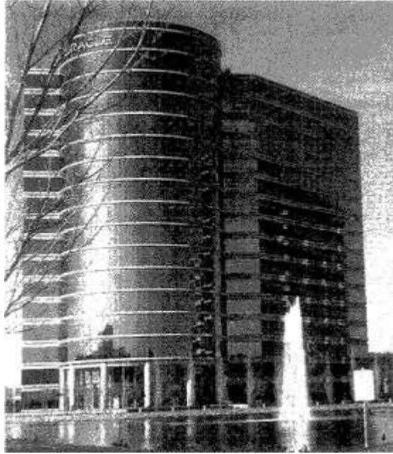
El edificio de oficinas Oracle, Redwood City, California.
