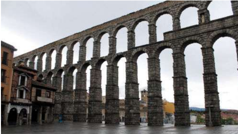
El acueducto romano de Segovia, España, construido con 148 arcos de 27 metros de altura.
