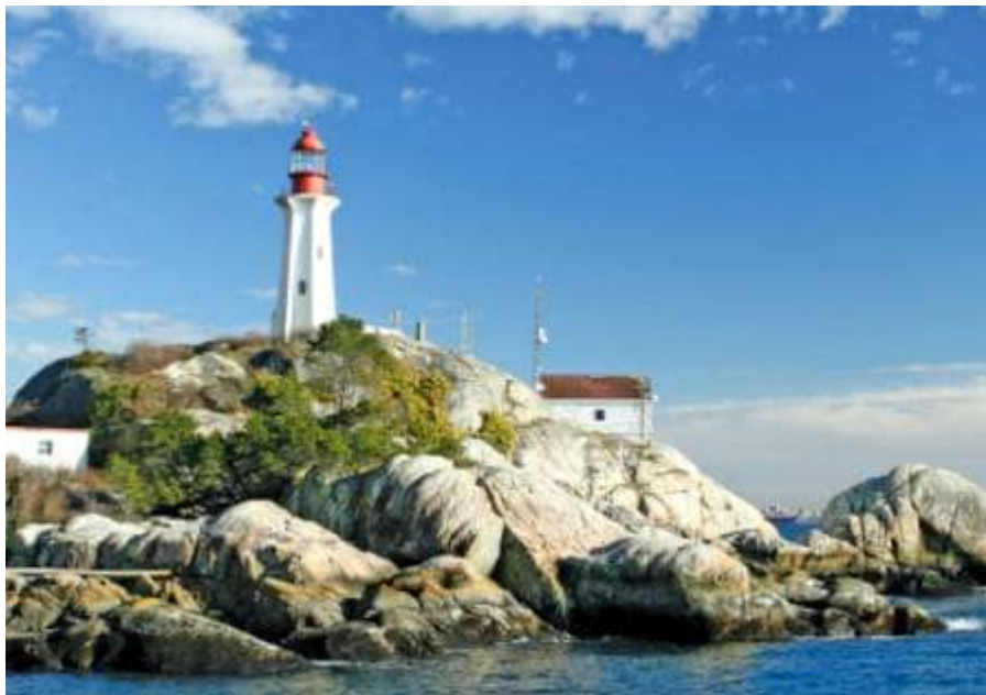
Figura III.4. Faro en Rocky Point, puerto de Yarmouth, en Inglaterra.
