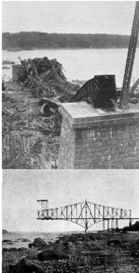
Dos fotografías del puente: una tomada justo antes de que se derrumbara y otra después.
