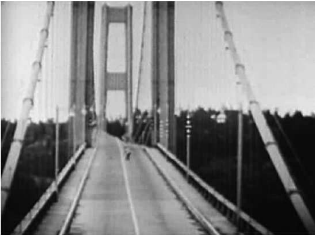
El puente de Tacoma en pleno proceso de resonancia. (Foto: archivos del autor)
